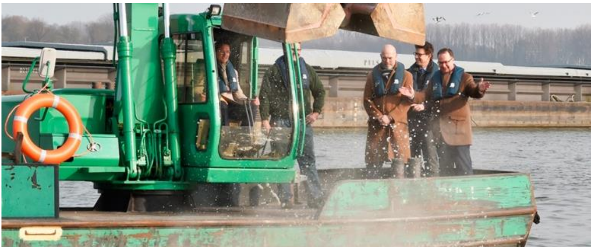
Figuur 4 Eerste stenen voor de aanleg van een getijdenpark bij het Mallegatpark in Rotterdam-Zuid (vigilate.pzh.nl, 2015).
