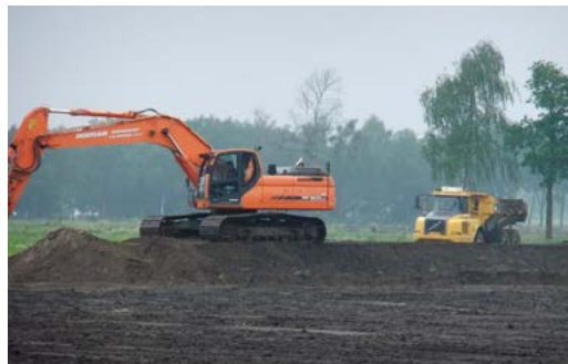
Grondwerk Lempens 2011 • PETER VAN SOEST
