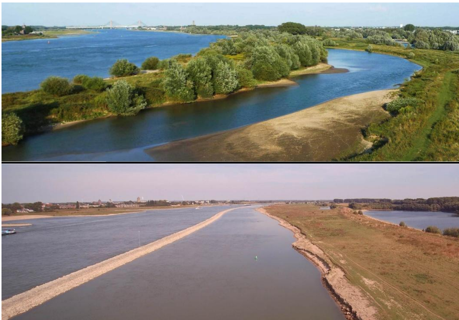
Figuur 3. Beeldimpressie: Boven: ‘Integraal meergeulenconcept’ (foto-bewerking geul Gamerense waard, Waal) Onder: ‘Constructief meergeulenconcept’ (langsdammen in de Waal nabij Tiel)
