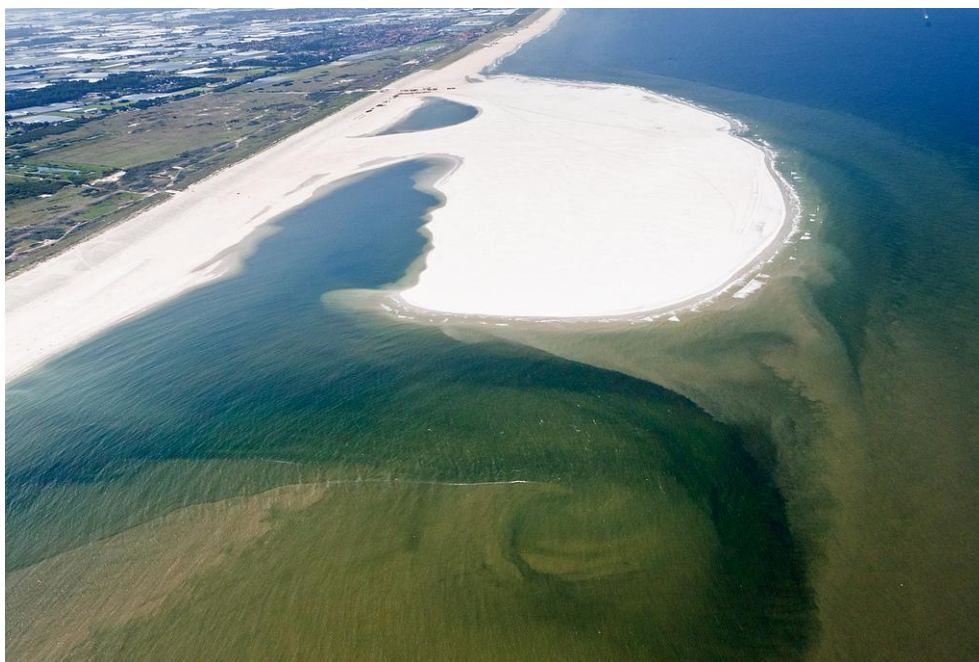
Foto 2: De Zandmotor op 11 juli 2011 vlak na aanleg. Duidelijk is het sedimenttransport te zien en de aangroei van een zandbank vanaf de punt van de Zandmotor. Foto Joop van Houdt.
