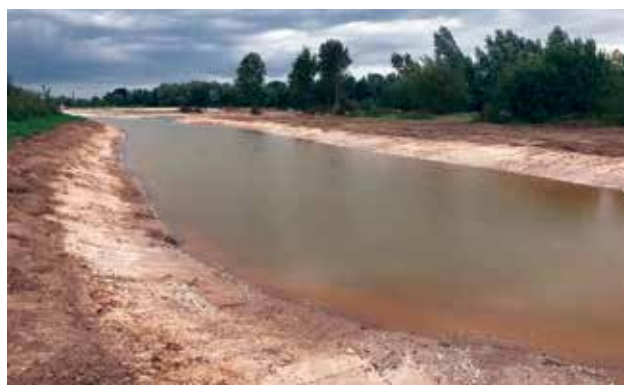
Kwelgeulen bij Roobeek en de Gebrande Kamp net na aanleg.
