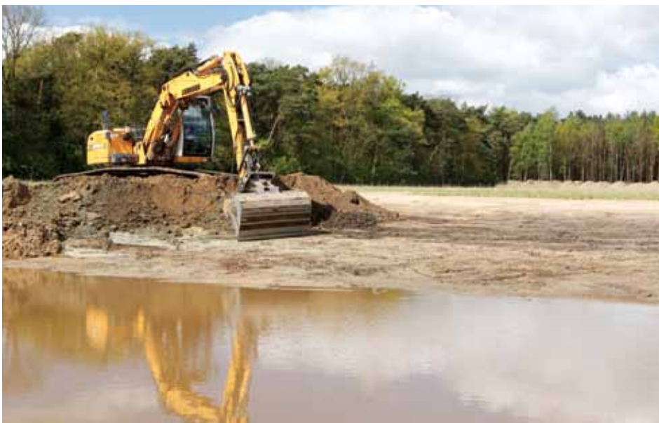
Graafwerk klimaatbuffer Kempen~Broek Bob Luijks
