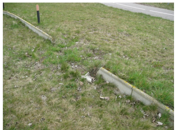
Figuur 4: Beschadigingen aan opstaande rand zuidzijde (links) en noordzijde (rechts)
