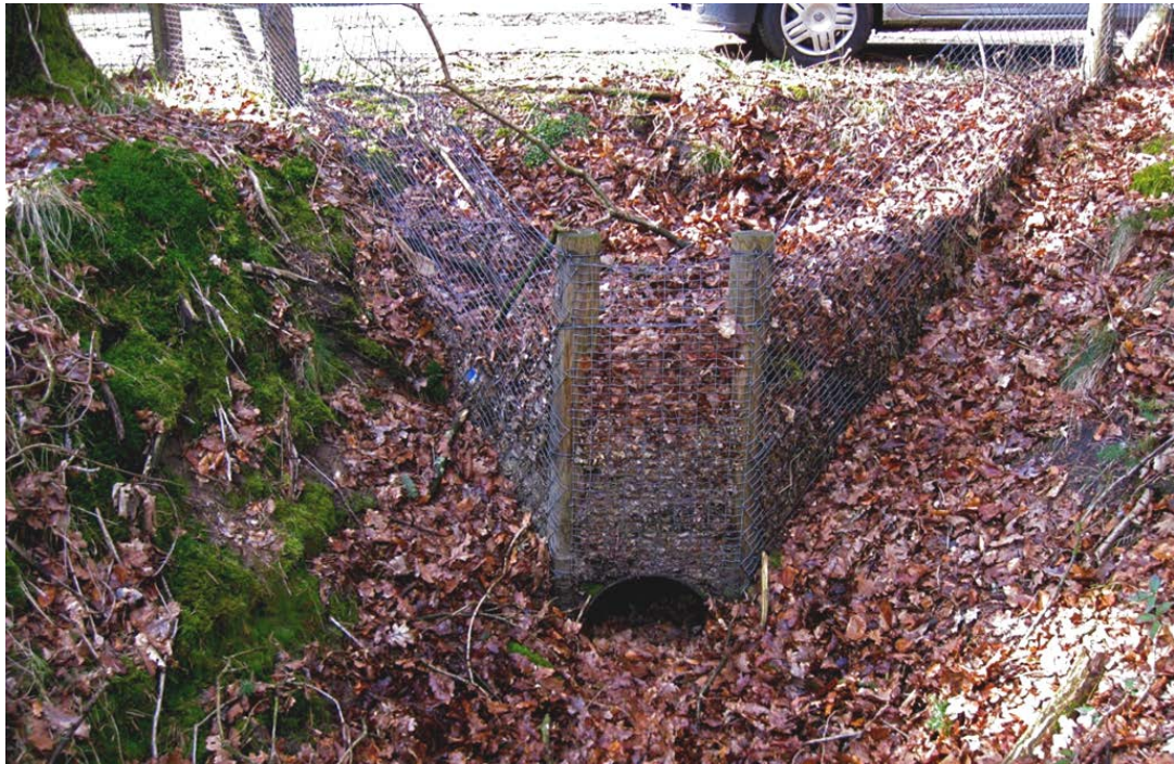
Figuur 1: Noordzijde opening faunatunnel 302061
