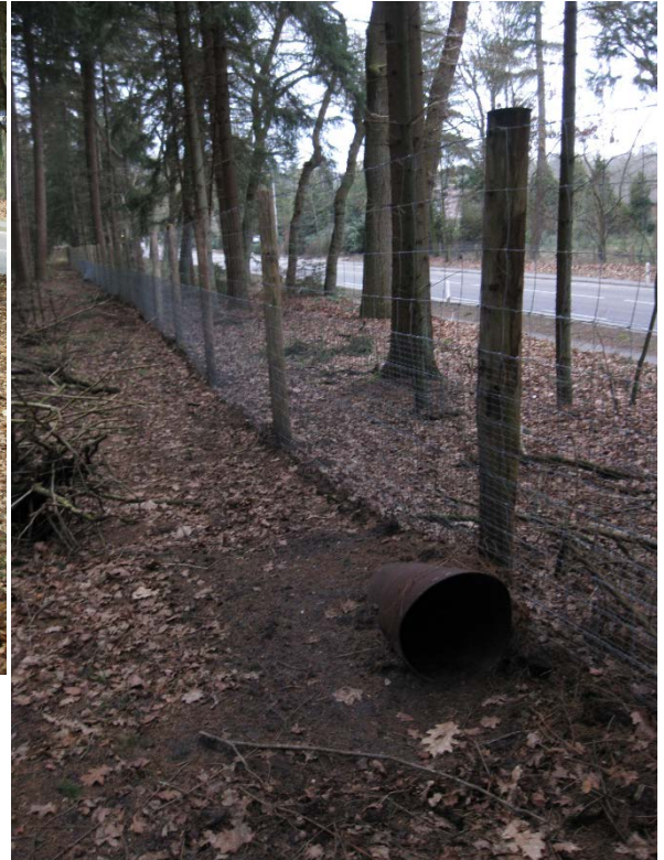
Figuur 2: Tunnelopening westzijde.
