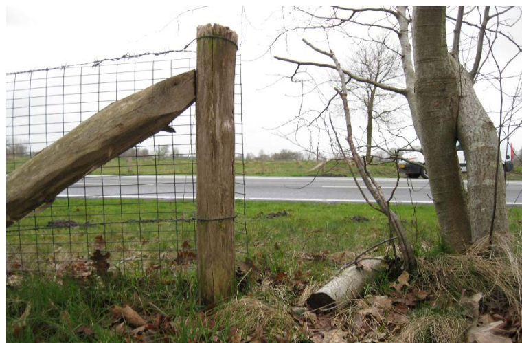
Figuur 4: Raster noordkant oostzijde sluit niet goed aan op bosschage.
