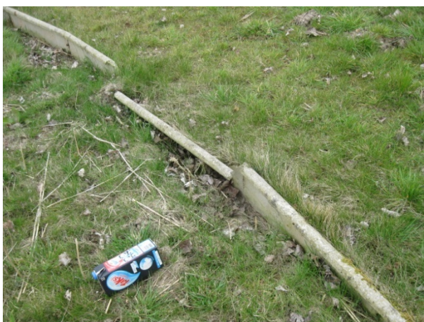
Figuur 4: Beschadigingen aan opstaande rand zuidzijde (links) en noordzijde (rechts)
