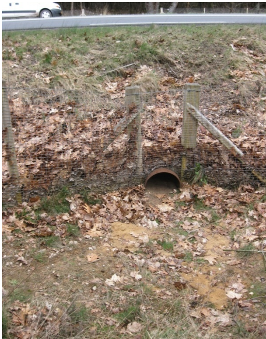
Figuur 2: Zuidzijde opening faunatunnel
