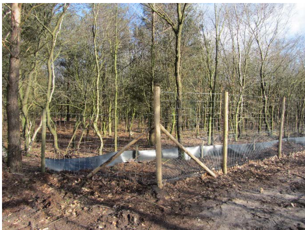
Figuur 3: Grof- en kleinwildrasters en tijdelijk amfibieënscherm zijn aanwezig.
