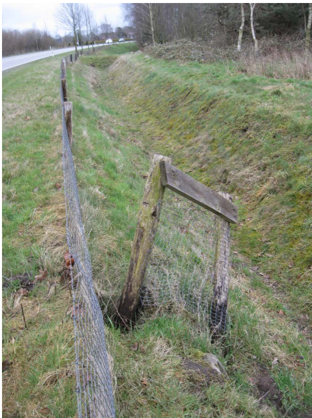
Figuur 2: Dwarsraster zuidzijde sluit niet goed aan op kleinwildraster.
