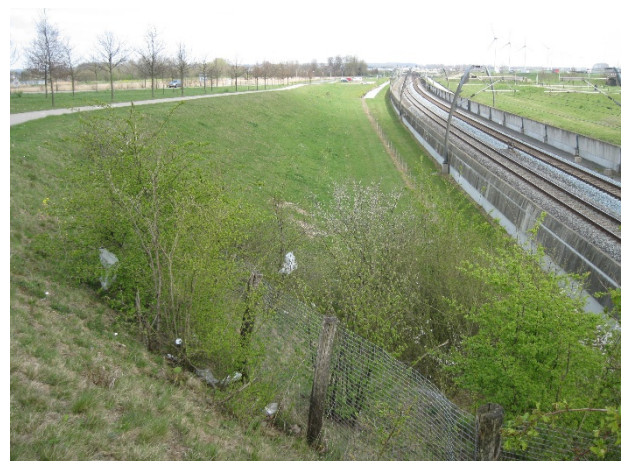
Figuur 3: Kleinwildraster oostzijde tunnel.
