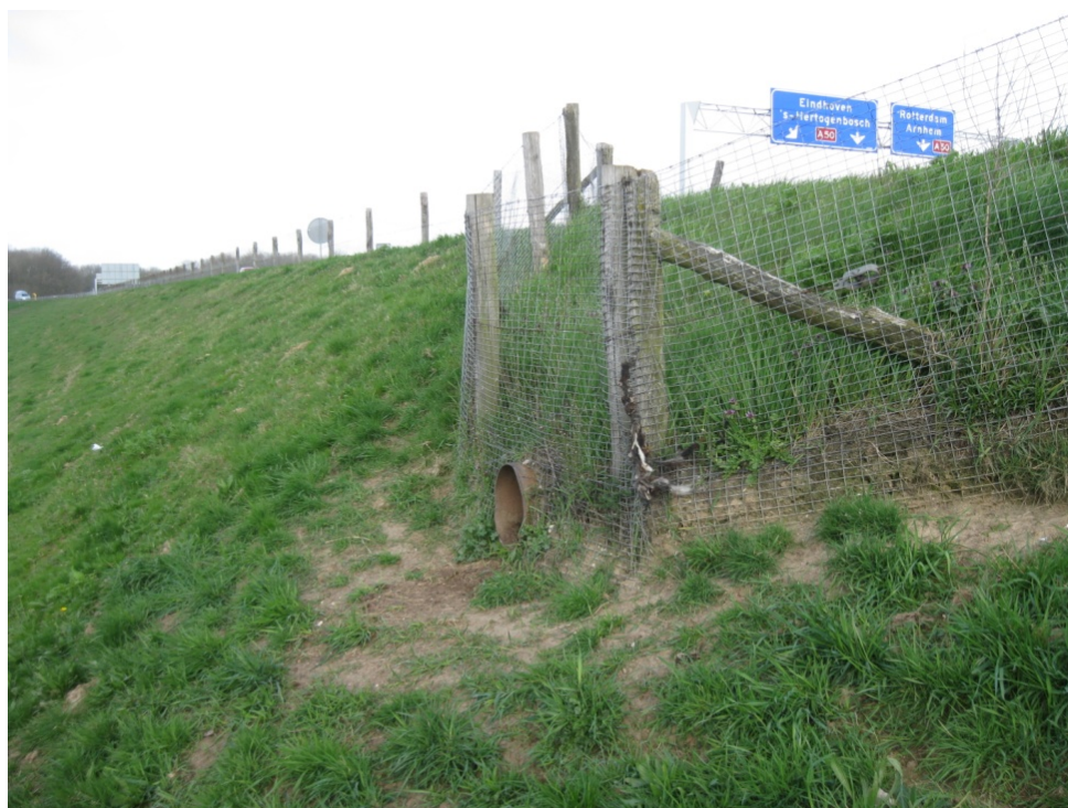
Figuur 2: Tunnelopening zuidzijde.
