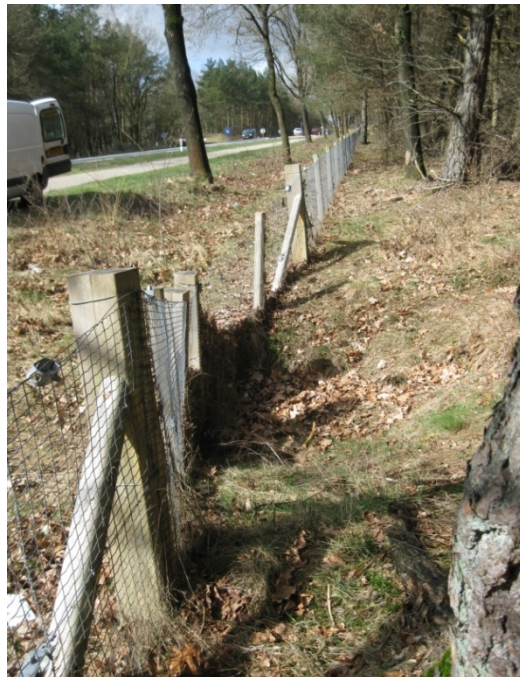
Figuur 3: Noordzijde opening faunatunnel
