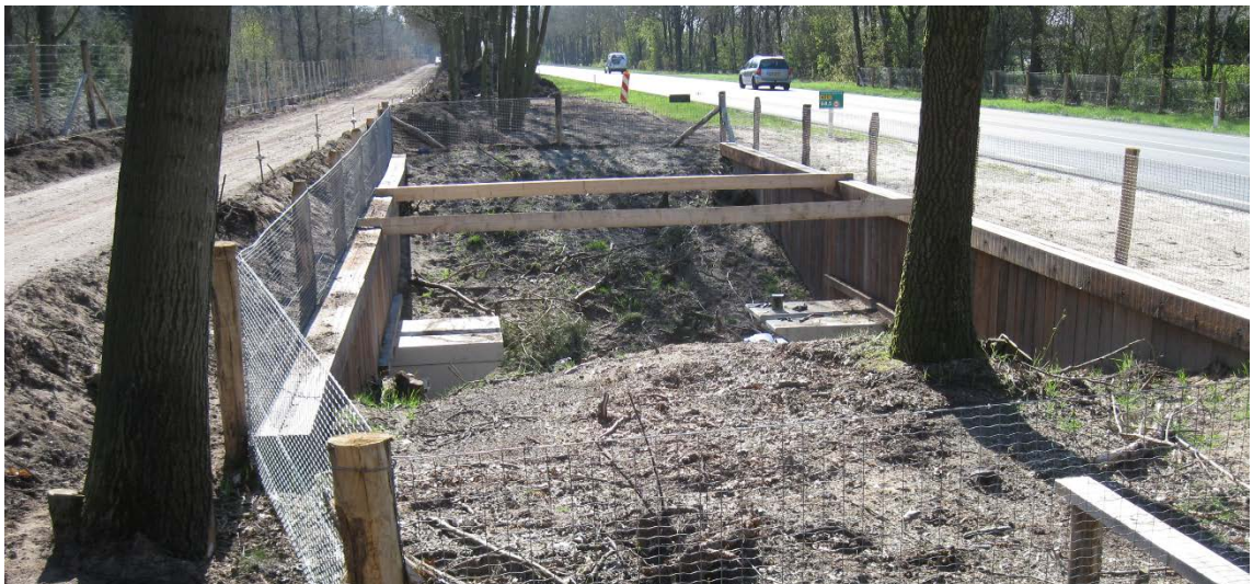
Figuur 2: Faunatunnels 310089a (links) en 310089 (rechts) sluiten op elkaar aan.
