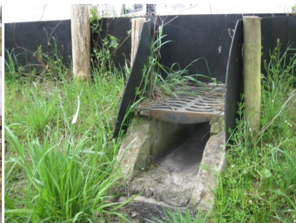
Figuur 1 (links): Het amfibieën roostertunnel is 51,75 meter lang.
