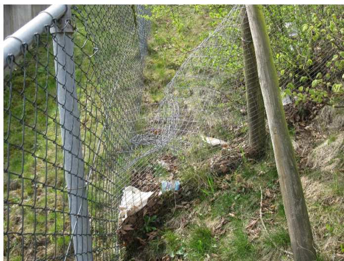
Figuur 4: Kleinwildraster oostzijde is beschadigd
