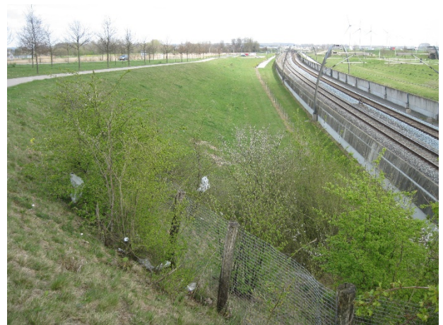
Figuur 3: Kleinwildraster oostzijde tunnel.
