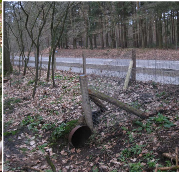
Figuur 4: Tunnelopening oostzijde.
