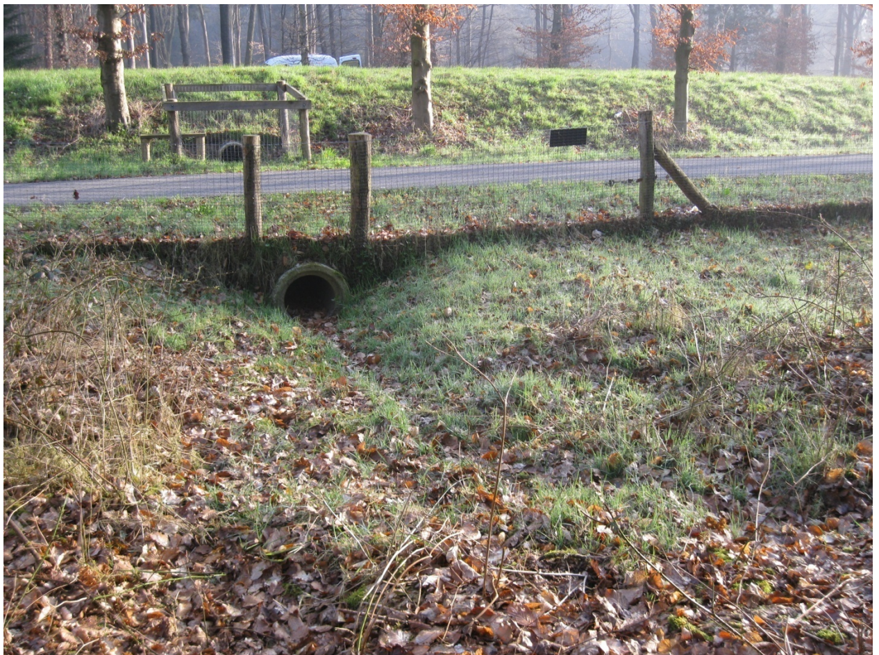
Boven: Openingen beide tunneldelen zuidzijde
