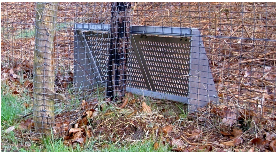
Figuur 30: Nieuw type dassenpoortje met gesplitst luikje en lichter materiaal.
