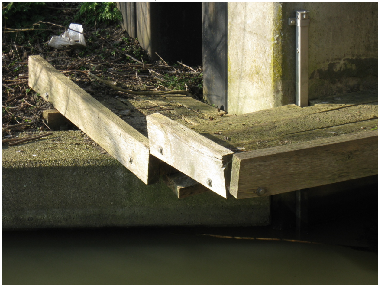
Boven: Loopstroken noord en zuid aan de oostzijde van de duiker. Onder: Defecte loopstrook noord aan de westzijde.
