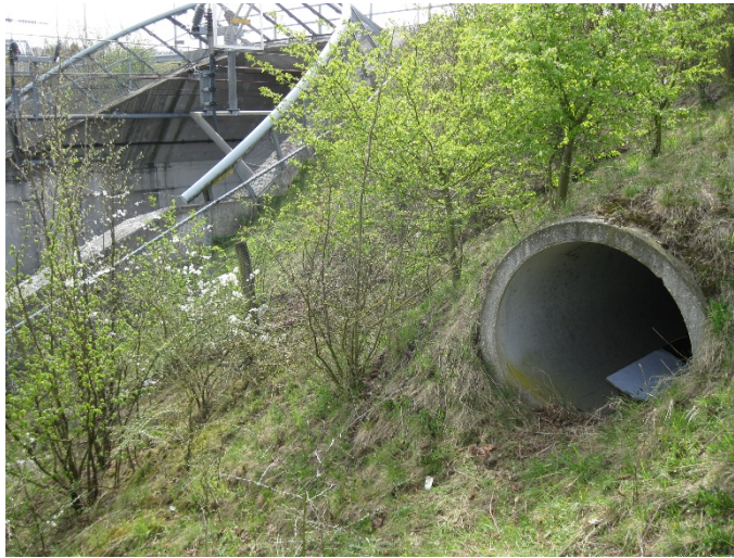
Figuur 1: opening oostzijde in talud, naast het spoor.
