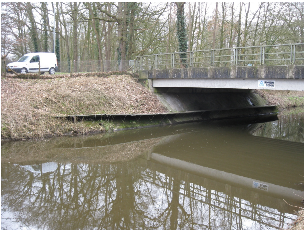
Boven: Loopstrook aan zuidzijde onder de duikerbrug
