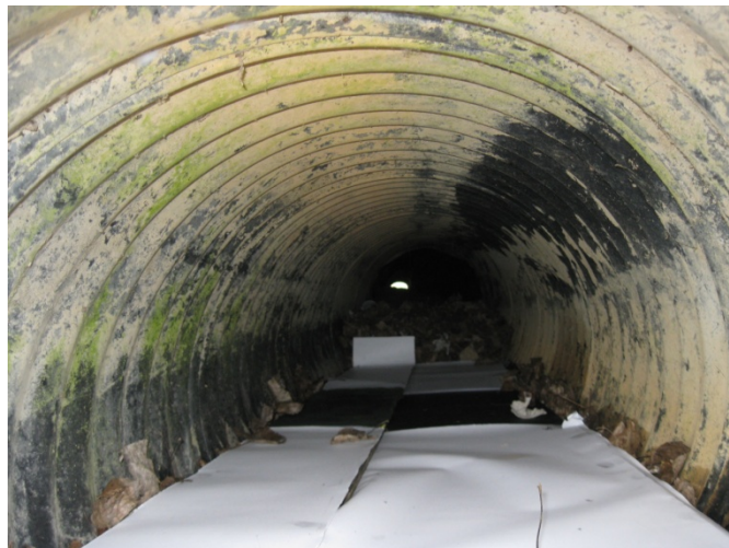
Figuur 3: Tunnelopening vanaf zuidzijde met sporenplanken.
