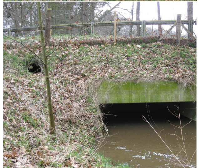
Figuur 2: Tunnelopening oostzijde.
