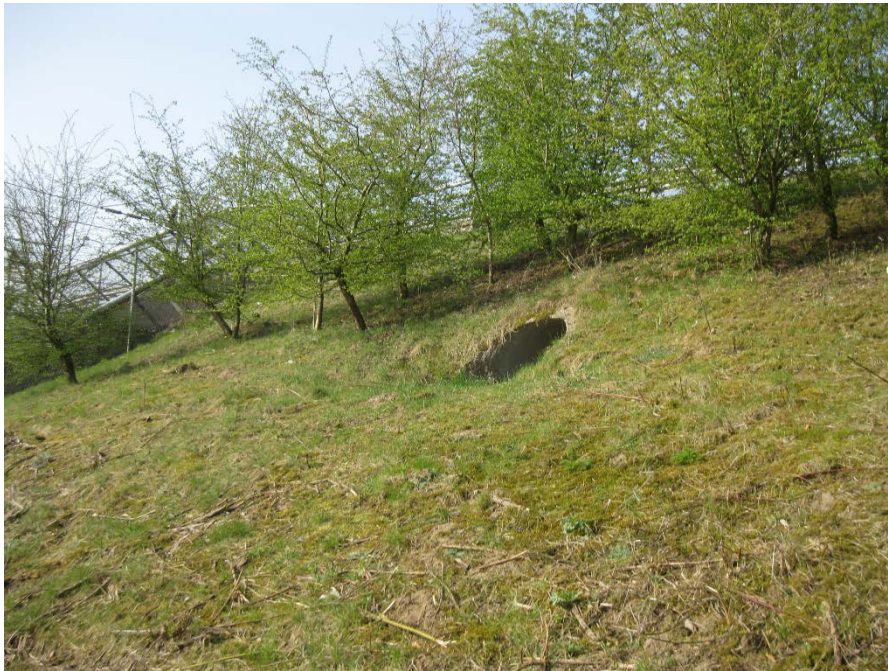
Figuur 1: Opening oostzijde in talud naast Betuwelijn.
