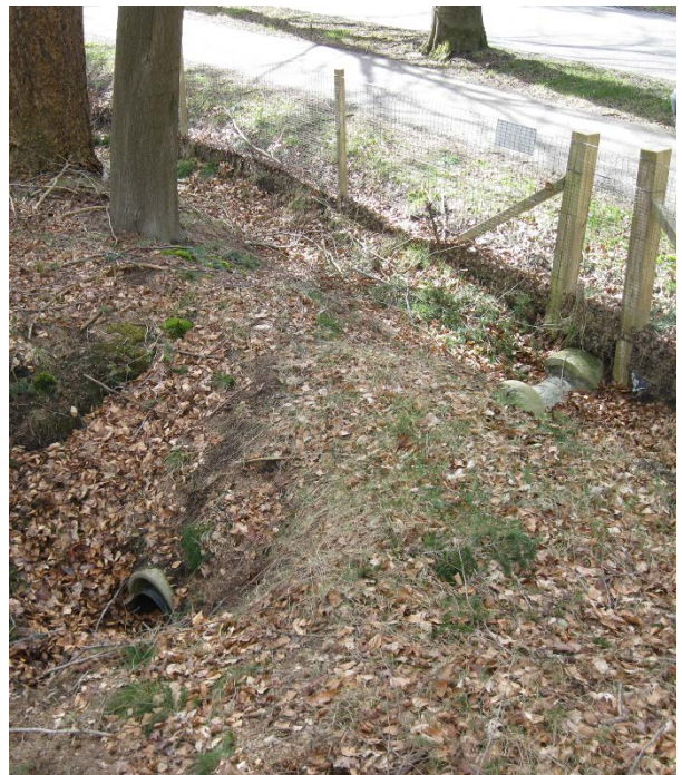
Figuur 4: Het deel van de voorziening bij het raster is gerepareerd.
