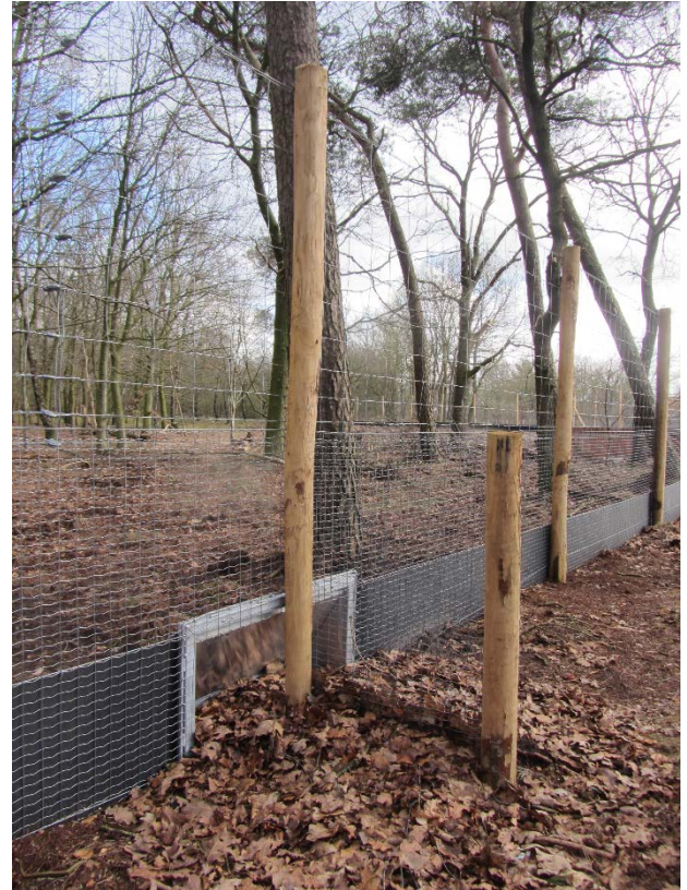
Figuur 2 (boven): Combinatie wildraster met dassenpoortje.
