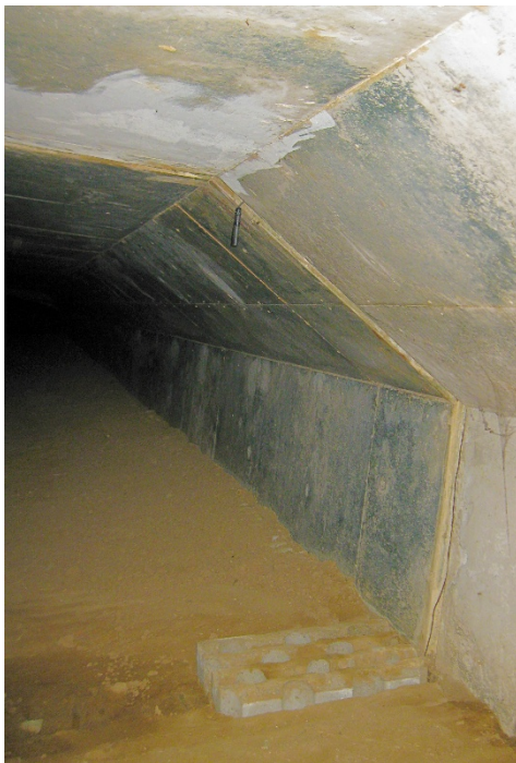
Figuur 4: Batlogger midden in duikerbrug.
