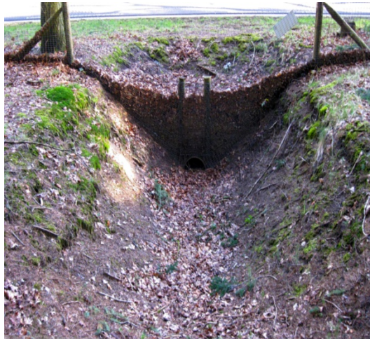
Figuur 3: Zuidzijde opening faunatunnel 302061
