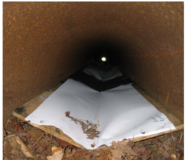
Figuur 3: Faunatunnel met sporenplank
