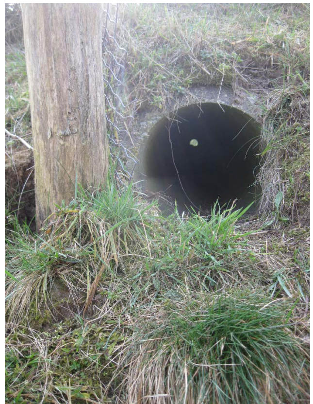
Figuur 3: Doorzicht faunatunnel vanaf noordzijde.
