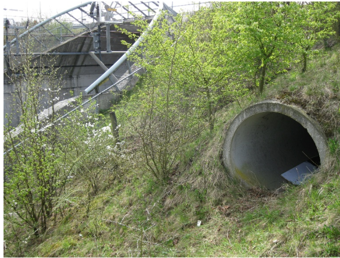
Figuur 1: opening oostzijde in talud, naast het spoor.
