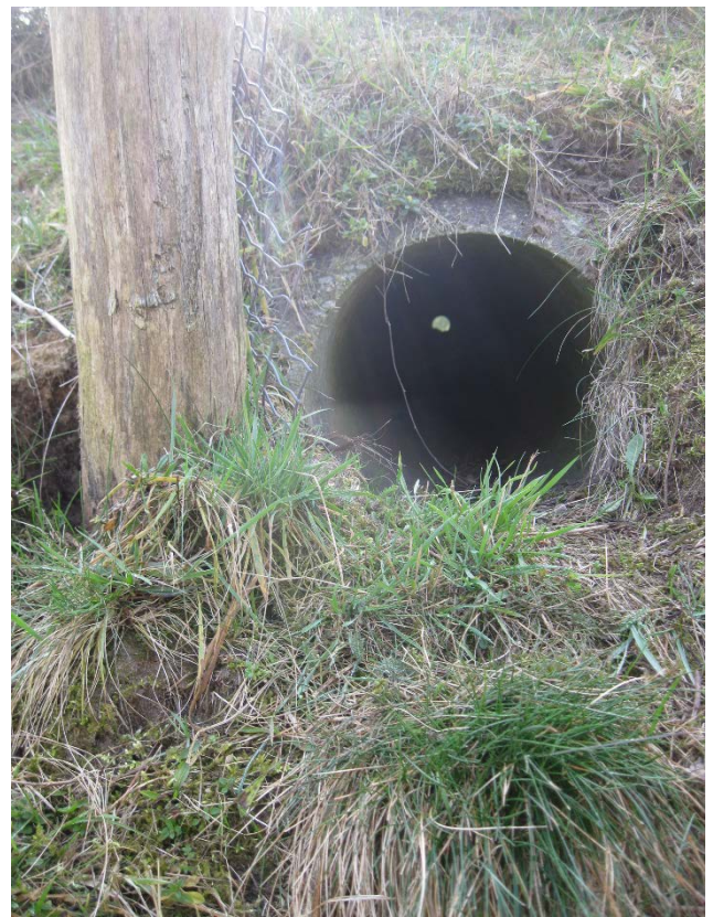
Figuur 3: Doorzicht faunatunnel vanaf noordzijde.
