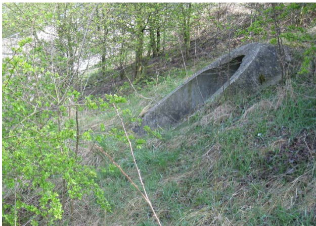
Figuur 3: Tunnelopening aan westzijde.
