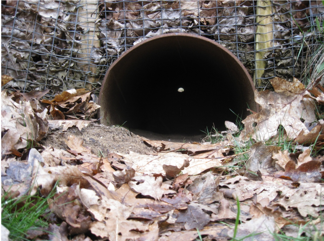
Figuur 1: Zuidzijde opening faunatunnel met doorzicht
