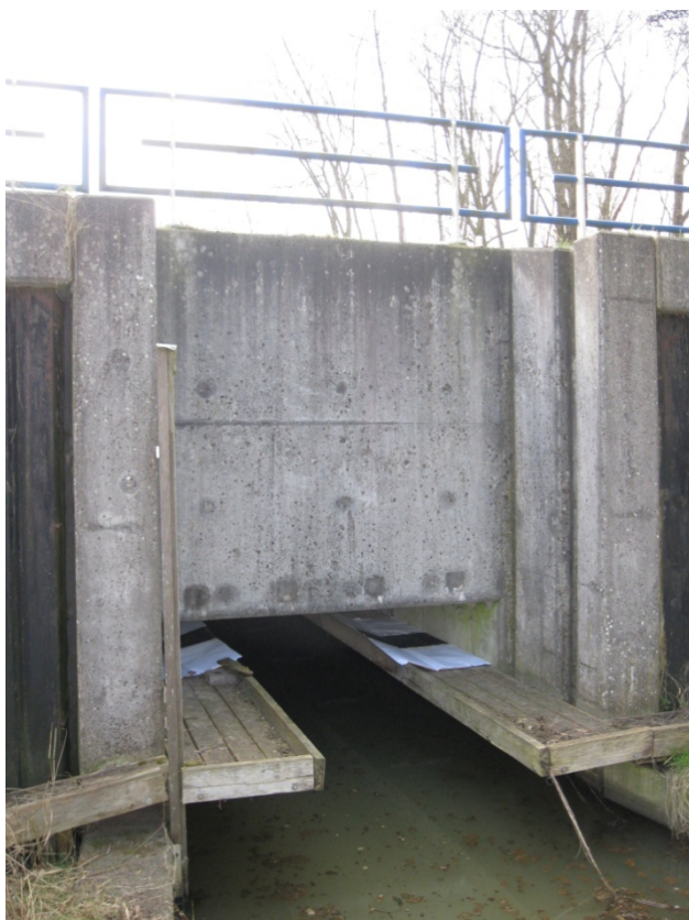
Boven: Loopstroken noord en zuid aan de oostzijde van de duiker. Onder: Defecte loopstrook noord aan de westzijde.
