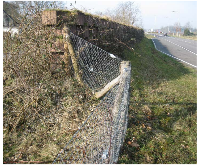
Figuur 1 (boven): kleinwildraster aan zuidzijde sluit aan op geluidswal.
