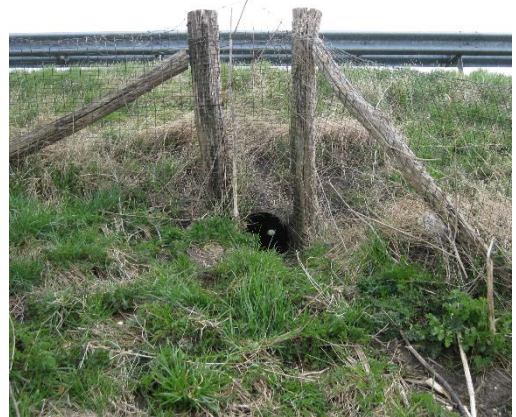
Figuur 4: Tunnelopening met doorzicht aan westzijde.
