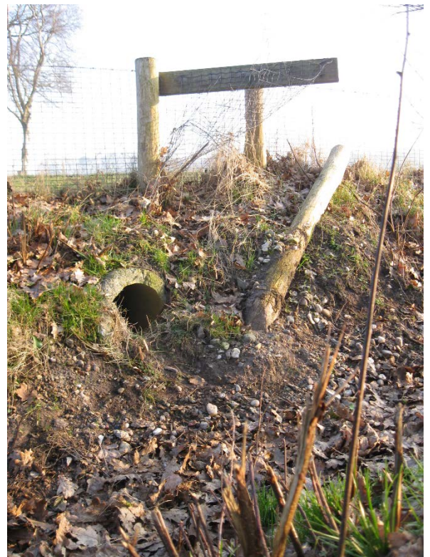
Figuur 3 (onder): Opening faunatunnel zuidzijde met kapot dwarsraster.
