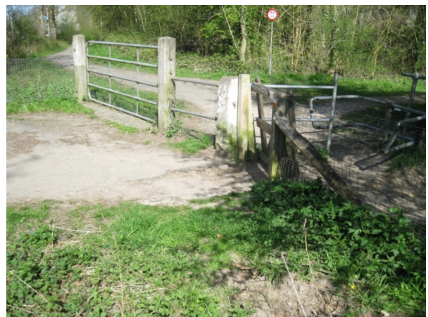
Figuur 5: Toegangshek in raster noordzijde.
