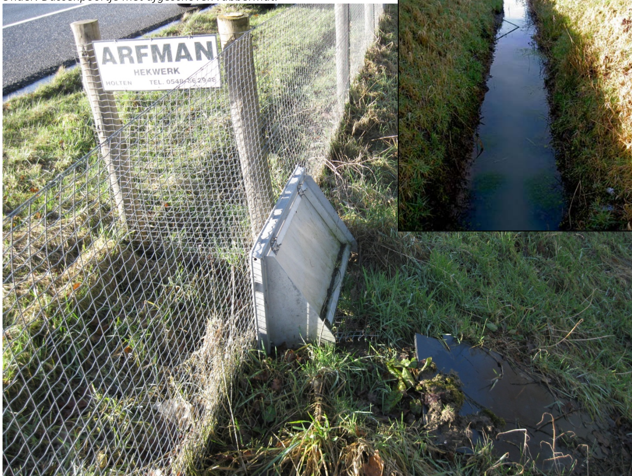
Boven: Opening noordzijde. Foto inzet: Bermsloot met front duiker. Onder: Dassenpoortje met afgeschoven rubbermat.
