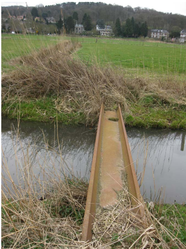
Figuur 4: Stalen balk aan zuidzijde over sloot.
