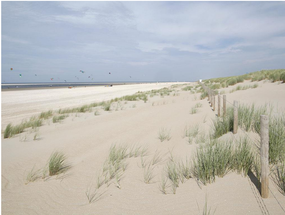
Foto 21: Op de overgang van strand naar de zanddijk van de Delflandse kustversterking is een langgerekte keten van jonge duintjes ontstaan.
