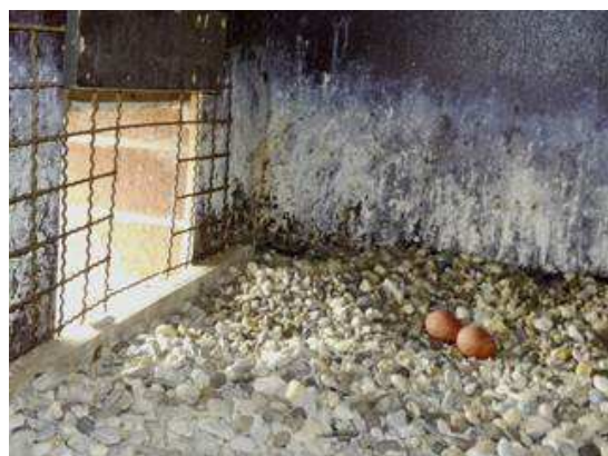
Foto 83. Na het plaatsen van betonijzer Voor de invliegopening, is de Oehoe niet meer gezien (E. Klöcker).
