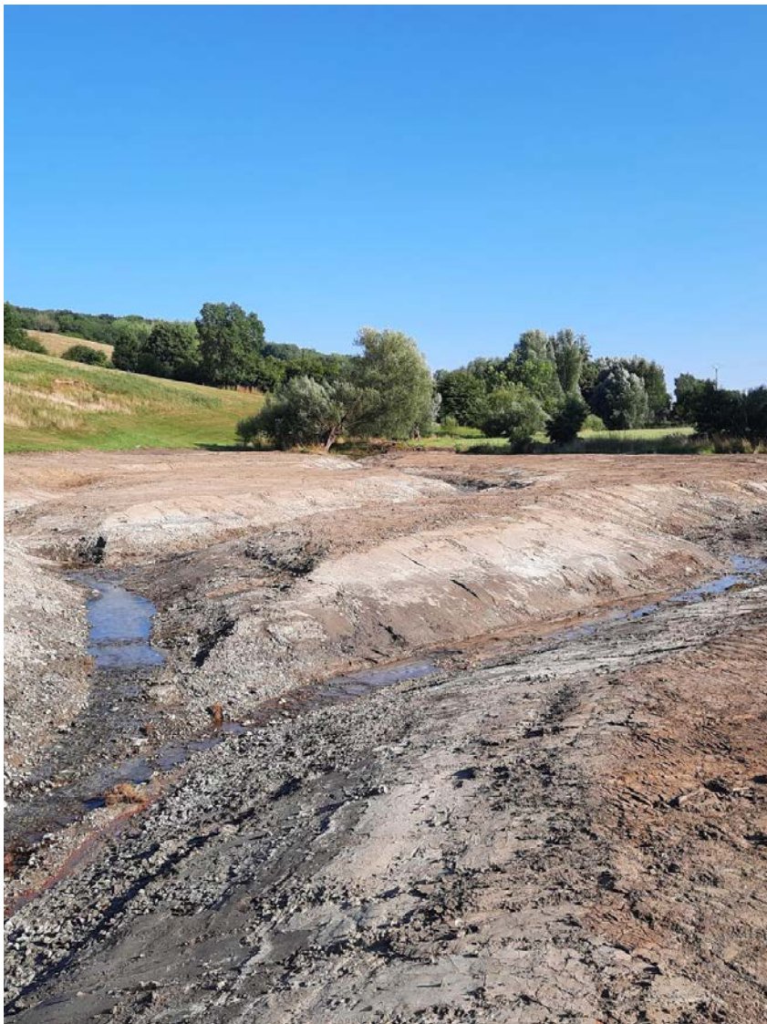
Exemple de restauration d'un ruisseau dans la partie amont de la Gulp, où le cours d'eau peut à nouveau occuper toute la largeur de la plaine alluviale.
