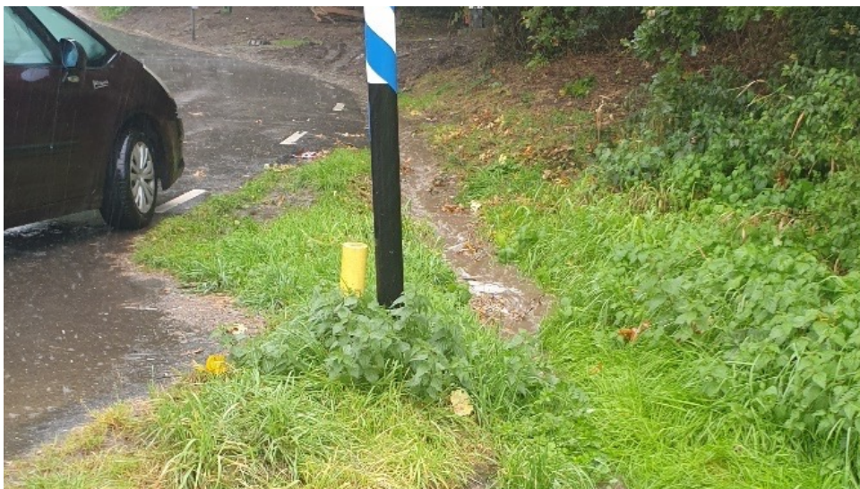
Exemple d'eaux pluviales détournées de la route et collectées sur le bas-côté de celle-ci (© Bureau Stroming).
