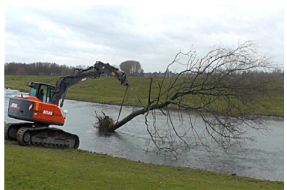
Foto 6, 7: Stalen ketting door oog in de boom (boven) en plaatsen boom in de vistrap bij Amerongen
