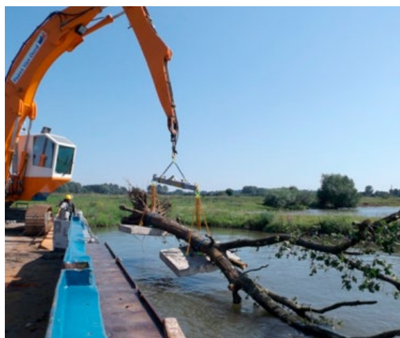
Foto 9, 10: Het afzinken van de bomen is precisiewerk: het is dan ook belangrijk dat de kraanmachinist ter plekke de diepte en de actuele plaats van het schip en de bomen in beeld heeft.
