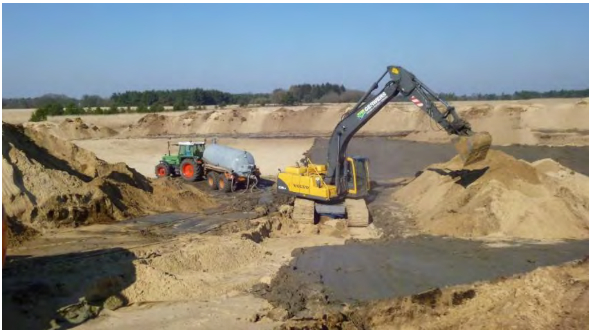
Figuur 7. De aanleg van het grote wisentven (circa 1500 m 2 ) met een dikke kleibodem, noodzakelijk op de Veluwse zandgrond. Bron: Eric Klein Lebbink, Staatsbosbeheer
