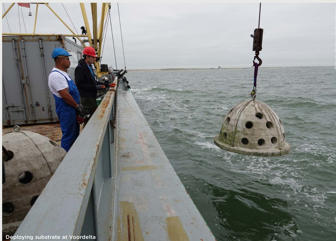
Deploying substrate at Voordelta
