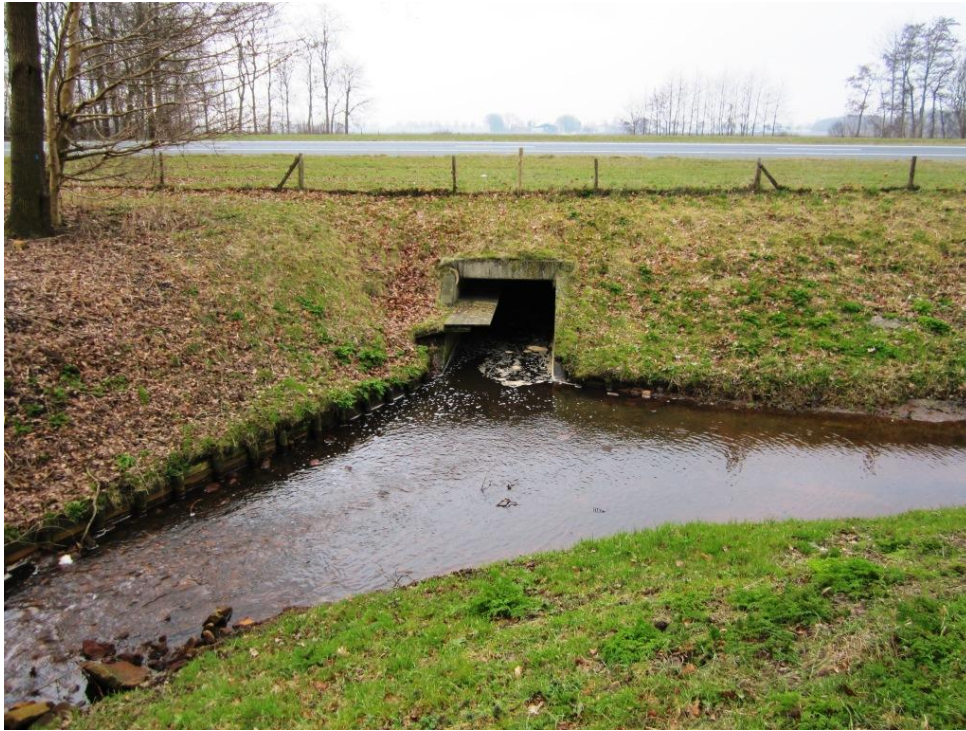
Foto 6. Voor otters te hoog aangebrachte looprichel in duiker Noordoostpolder.
