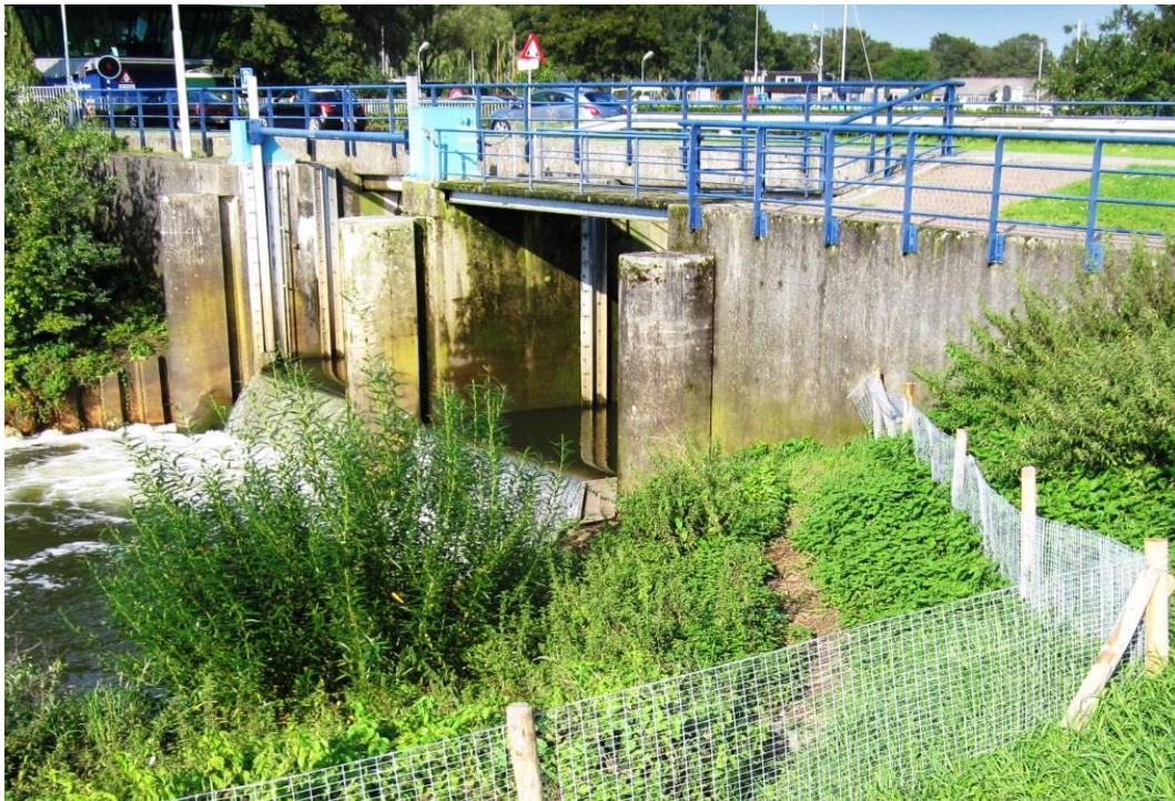
Foto 7. In de zomer van 2011 door het Waterschap gerealiseerde looprichel met begeleidende rasters bij de stuw van het Broekhuizerwater onder de B. Ubbinkweg te Doesburg.
