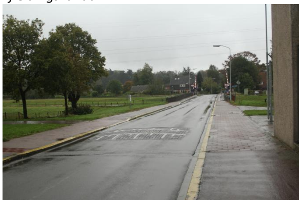
Verkeersdrempel bij sluis Eefde
