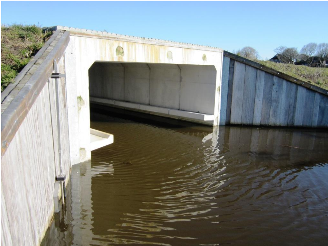
Foto 4. Nieuwe duiker met prefab looprichel. Wieden 2011.
